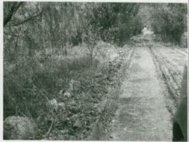
**FOTO No 2** La construcción de este carreteable facilitó el ingreso de volquetas con escombros; sin embargo el relleno fraccionó el cuerpo del humedal, situación que ocasiona impactos negativos al ecosistema.
